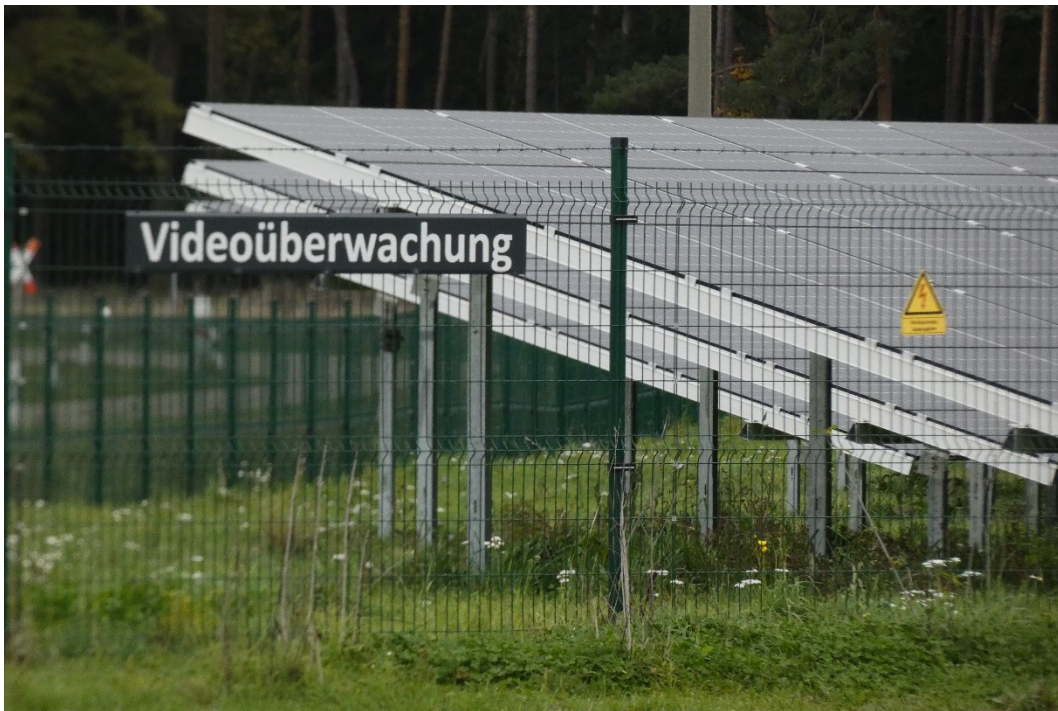
Abb. 2 Freiflächensolaranlagen werden aus Sicherheitsgründen in der Regel zugangsbeschränkt und teils überwacht.
