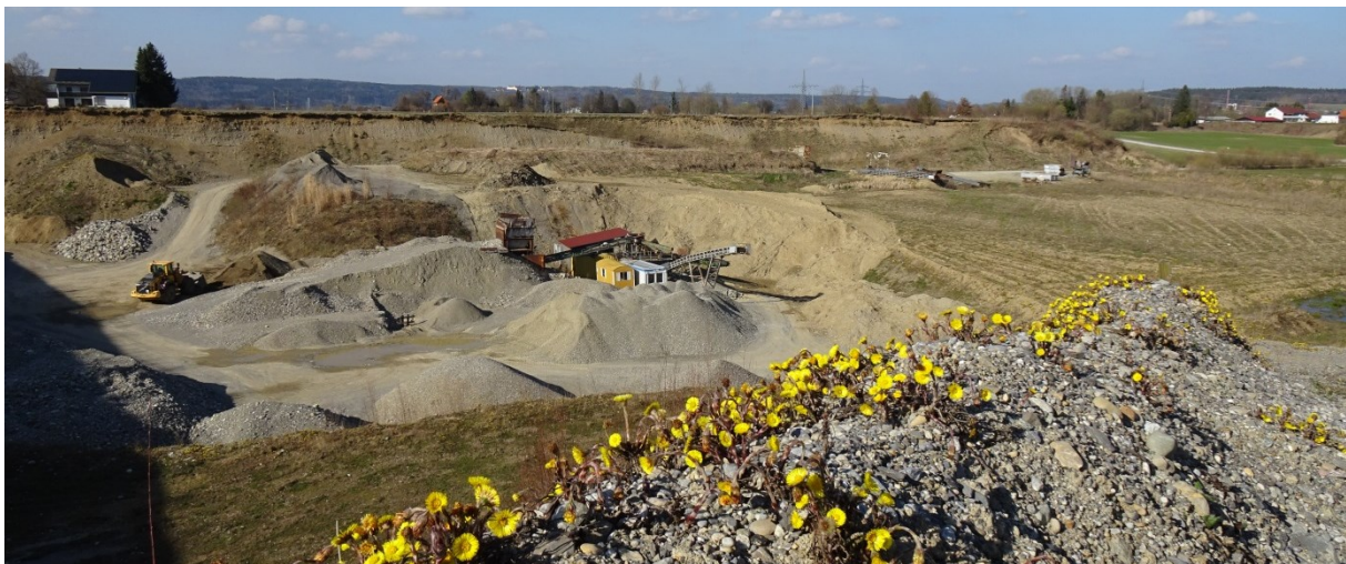
Blick von der Geländeoberkante in einen Teil des Gebiets mit noch bestehendem Abbau-/Umschlagsbetrieb.
