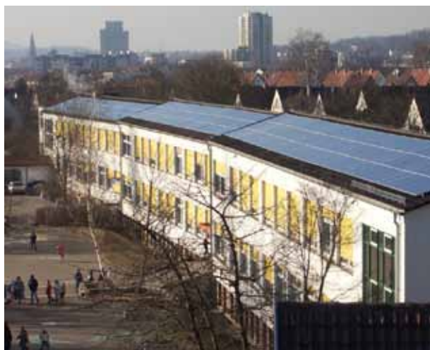
Photovoltaik-Anlage auf dem Dach der Geschwister-Scholl-Schule als eines der Leuchtturmprojekte (Foto: Stadt Kaiserslautern)
